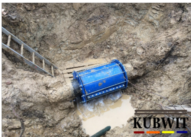
Konstrukcja nasuwki zapewnia prosty i szybki montaż na uszkodzonym rurociągu kielichowym
